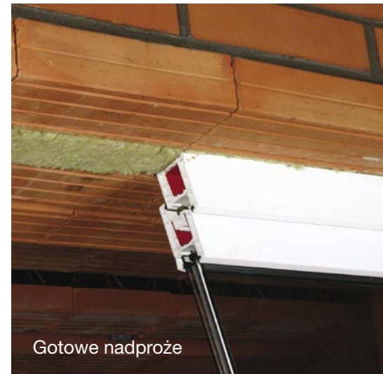
Rys. 12. Przykłady ustawiania belek nadprożowych Porotherm 11.5 i 14.5 dla różnej grubości murów
