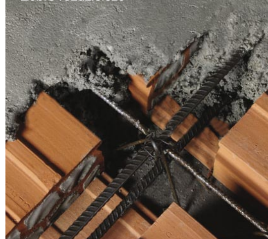
Betonowanie stropu
